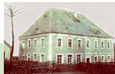
Das Landgerichtsgebäude erbaut 1762 um 1911
